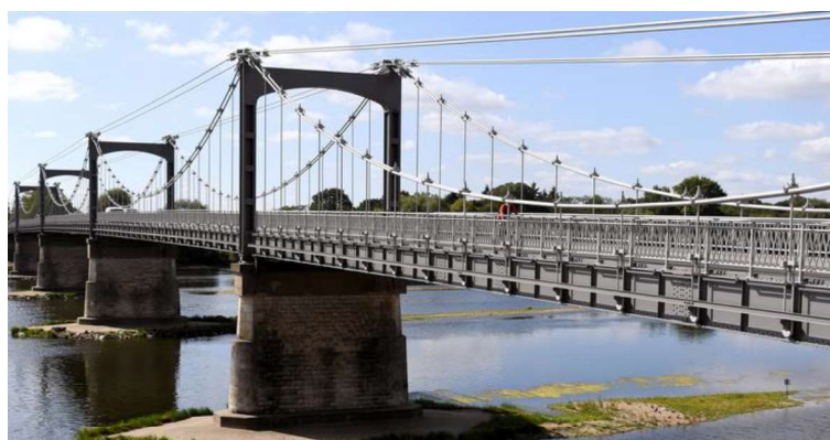
Figure 59 : Pont reliant Châteauneuf-sur-Loire à Sigloy
